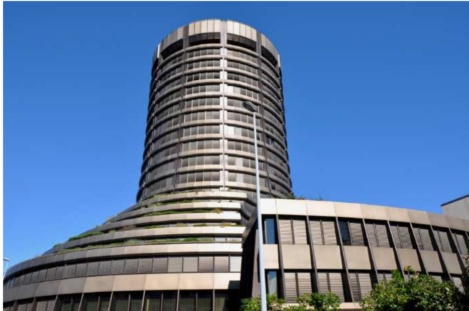
– Tour de la Banque des Règlements Internationaux– Bâle/Basel –
