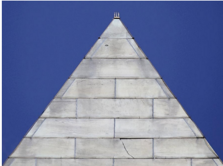
Pyramidion du Washington Monument endommagé en Août 2011
