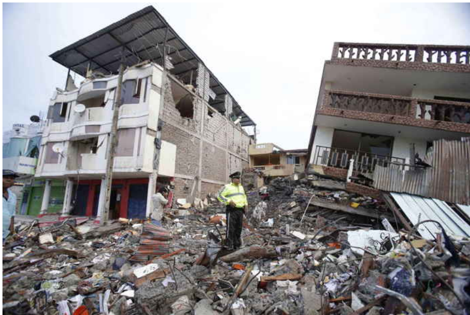
Des gravats d'un immeuble à Pedernales
