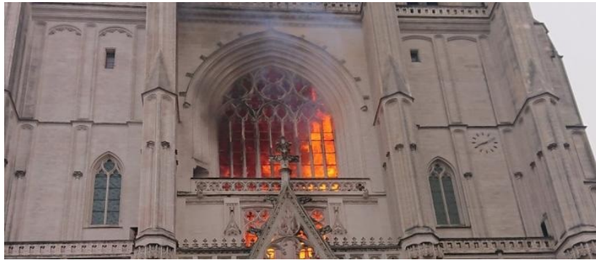
Incendie à l'intérieur de la cathédrale de Nantes le 18 Juillet 2020
