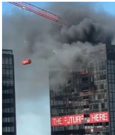
Incendie au dernier étage d'une des tours du WTC de Bruxelles
