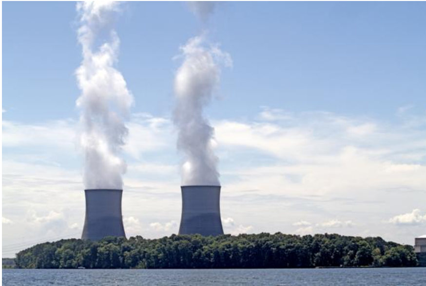
Tours de refroidissement de la centrale nucléaire Sequoyah
