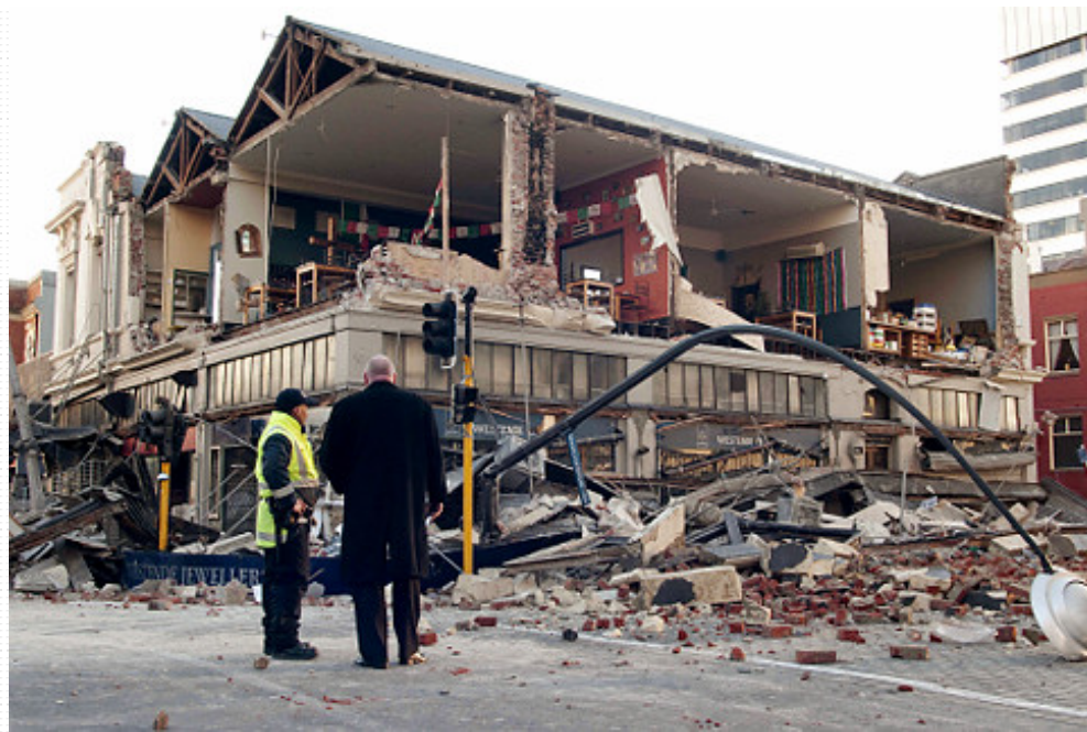
Séisme à Christchurch le 4 Septembre 2010
