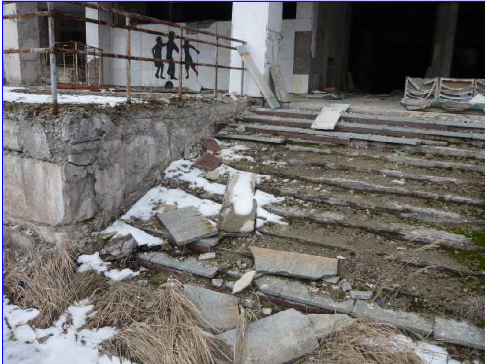
Accès à la terrasse d'un hôtel
